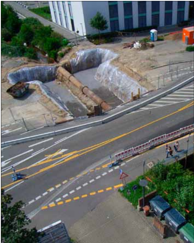
Kaum wiederzuerkennen: Nach dem Umbau präsentiert sich die Heinrich-von-Stephan-Straße in ganz neuem Gewand mit viel mehr Platz für Autos, Radler und Fußgänger. Sehr aufwändig waren die neuen Durchlassbauwerke für den Kronenmühlenbach und den Hölderbach (unten). (Fotos: A. J. Schmidt / P. Schley)
