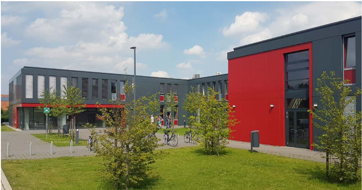
Das Institut für Energieforschung The Institute for Energy Research
