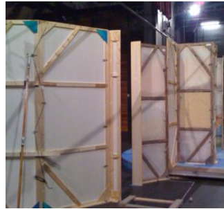
Abbildung 2.1.1: Flats Standard Rear Framing Lashing Quelle: hstech.org, Zugriff am 12.08.2025
