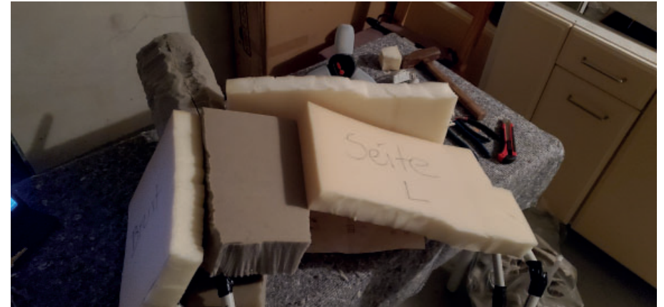
Abb.37: Anordnen der Schaumstoffblöcke (Eigene Aufnahme, 2025)
