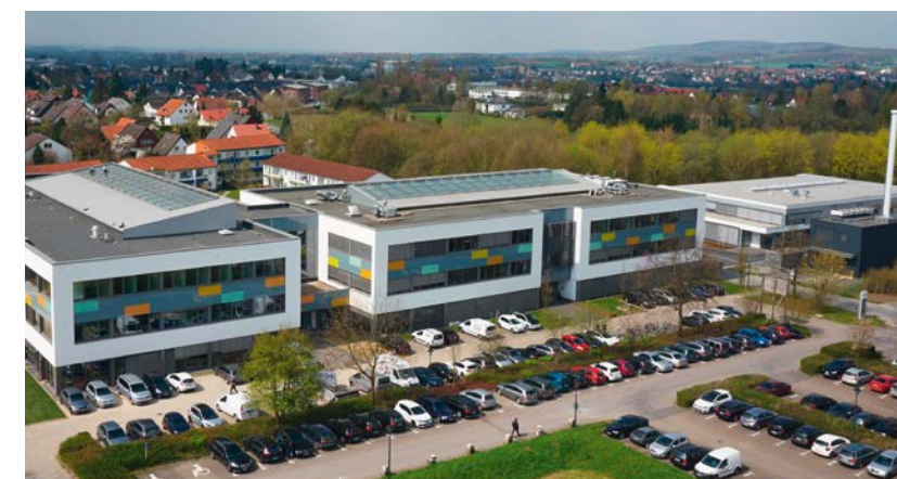
CIIT mit Erweiterungsbau (links) und SmartFactoryOWL (rechts)
