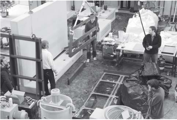
Für den Aufbau der Groß-Versuche braucht es jede Menge Manpower, um die sechs Quadratmeter großen Wände aufzustellen.
