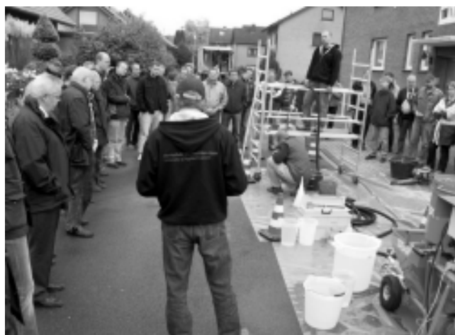
Einbau der Injektionslanze.
