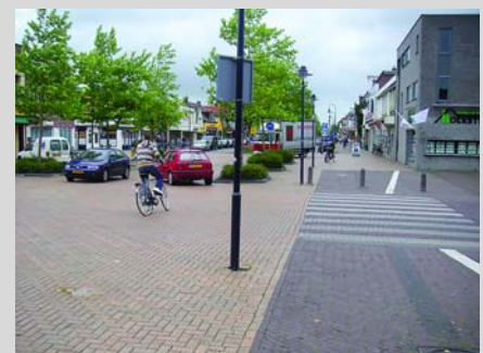
Bild 5: Knotenpunktzufahrt Noordkade/Zuidkade mit Baumscheiben zur Kanalisierung in Drachten, Niederlande
