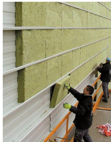
Abbildung 4: Einbau von Steinwollämmung (baunetzwissen.de)
