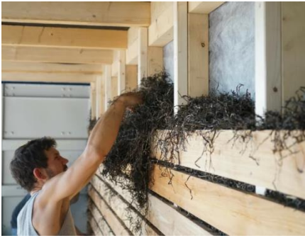
Abbildung 7: Einbau von Ostsee-Seegras (baunetzwissen.de)
