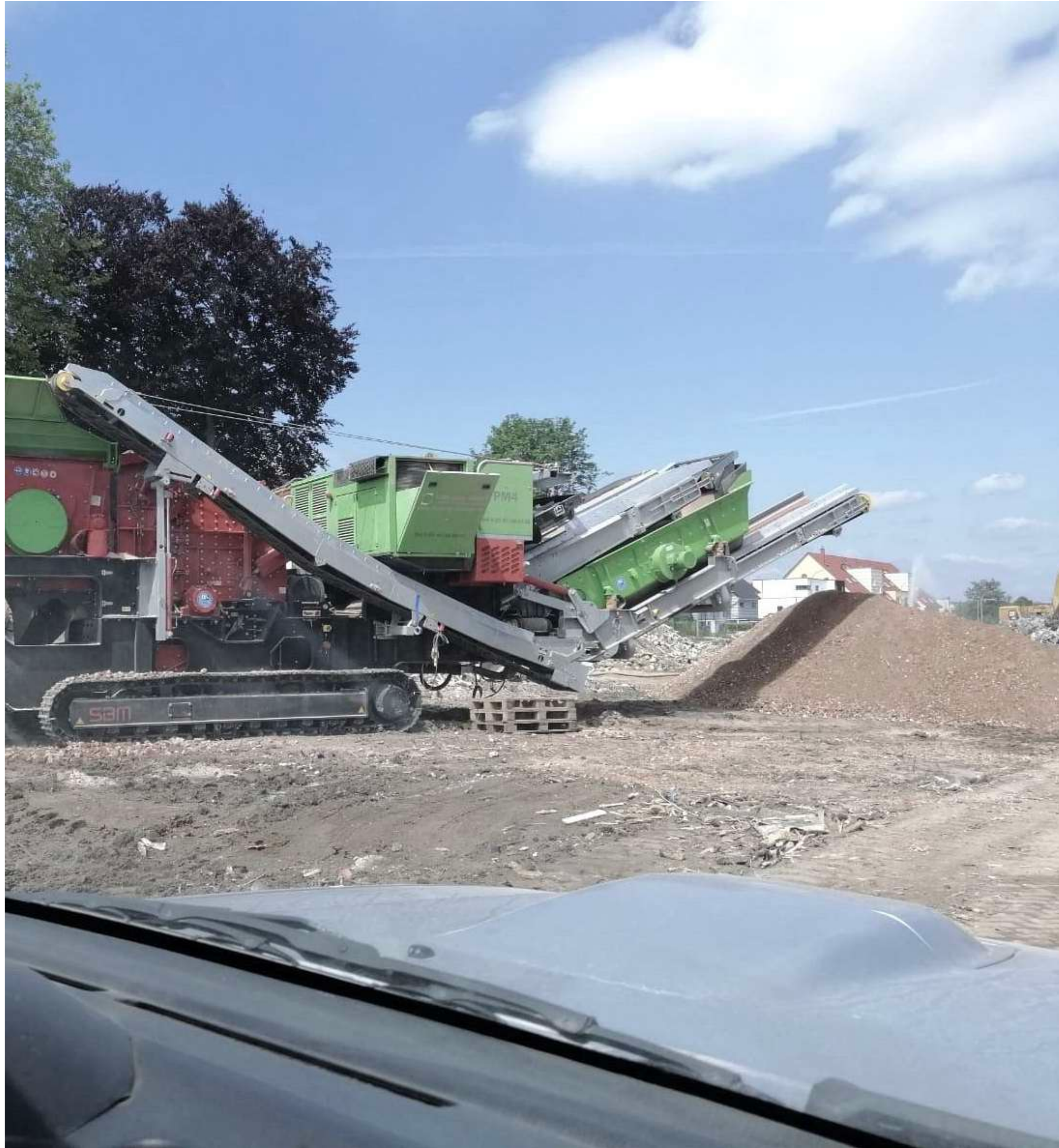
Zerkleinerung und Filterung des Bauschutts vor Ort
