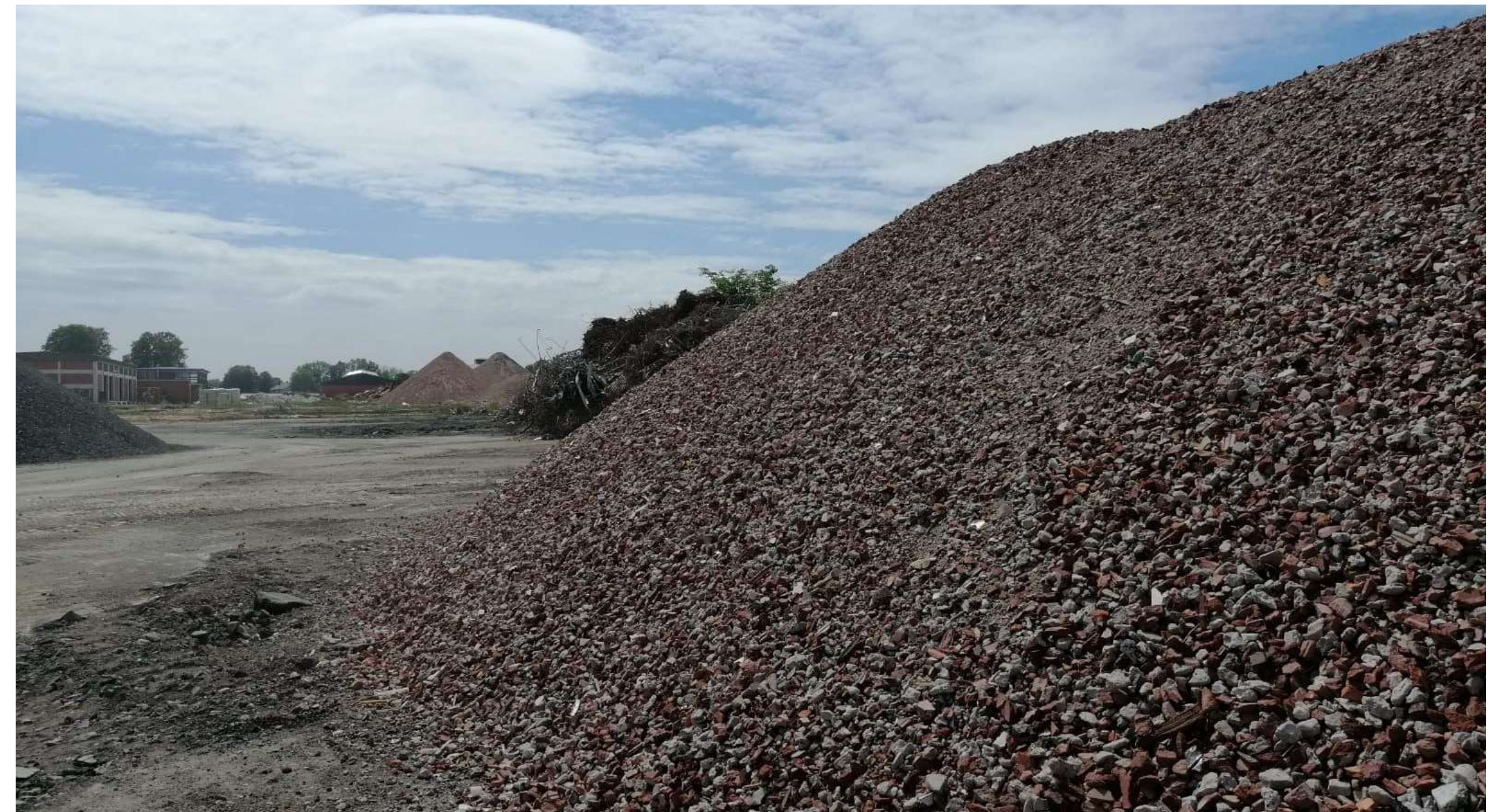
Ortsbegehung Baustelle 19. Mai 2020
