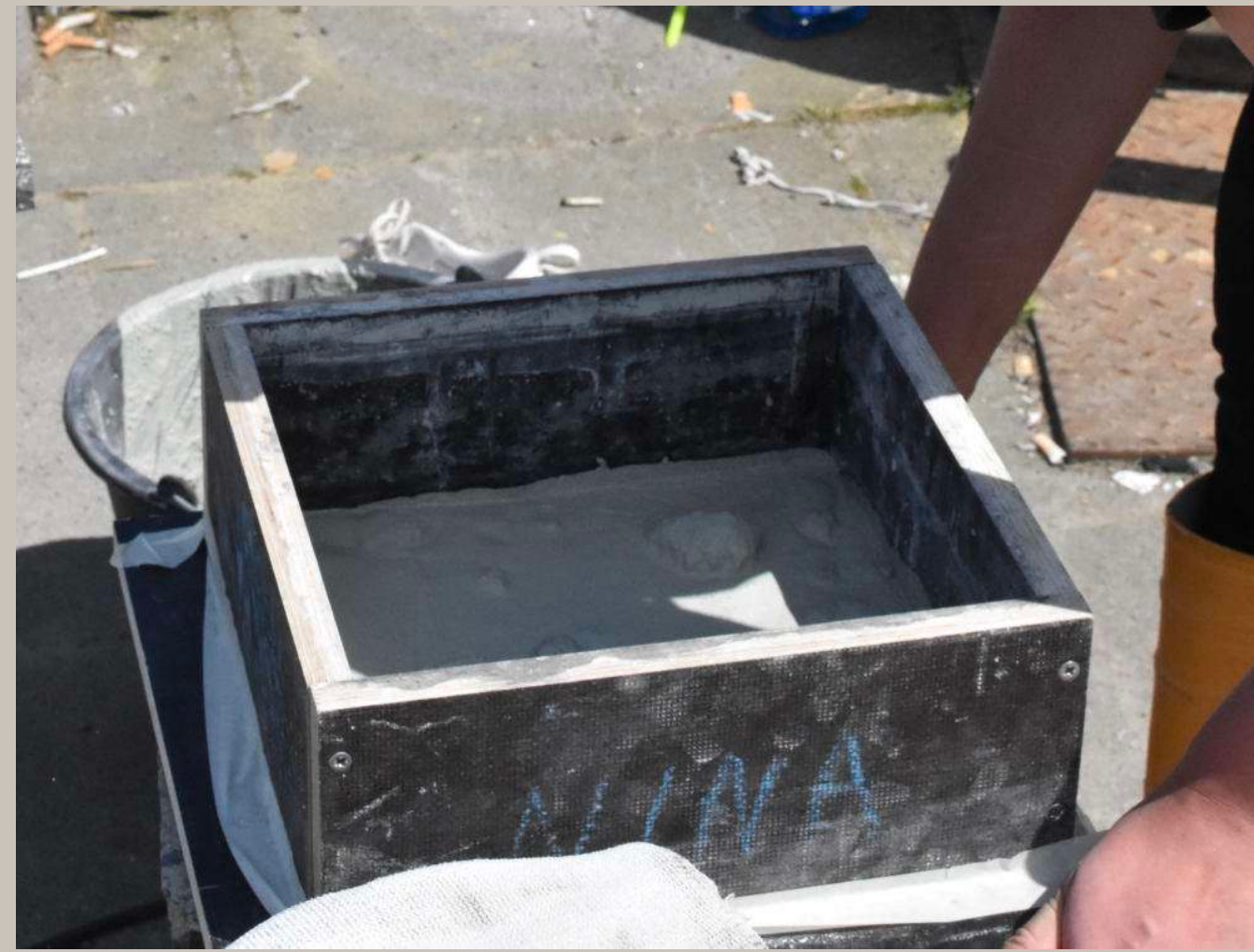
10. leichte Rüttelbewegung um Lufteinschlüsse zu lösen
