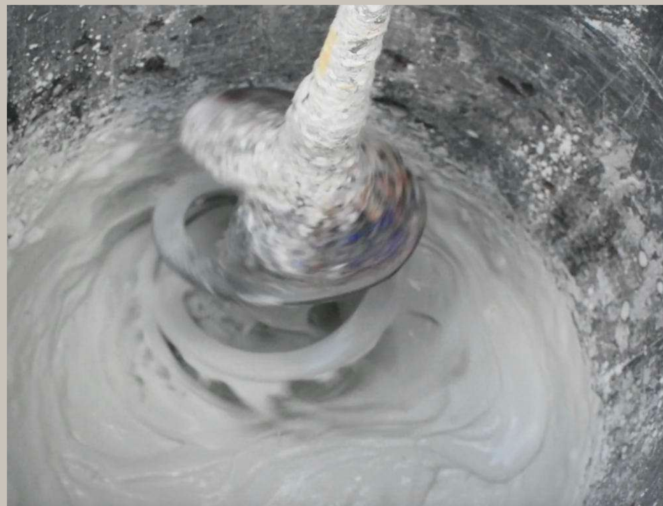
5. Herstellung der Zementmasse
