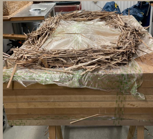
Typhafasern mit Magnesit besprühen und in die Schalung einfügen
