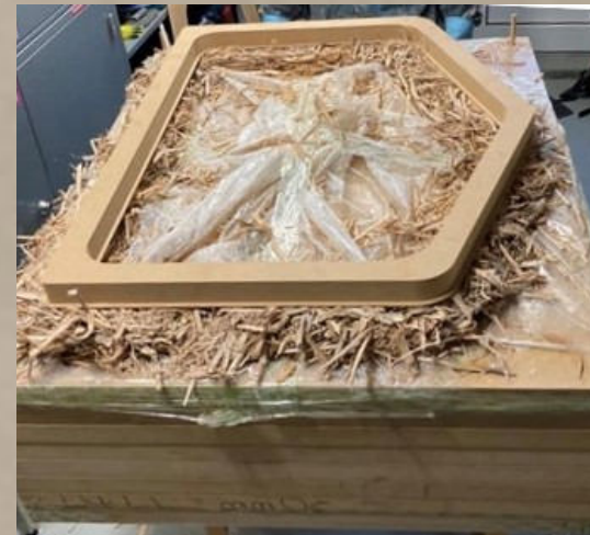
Nach und nach mit Schalungsring pressen
