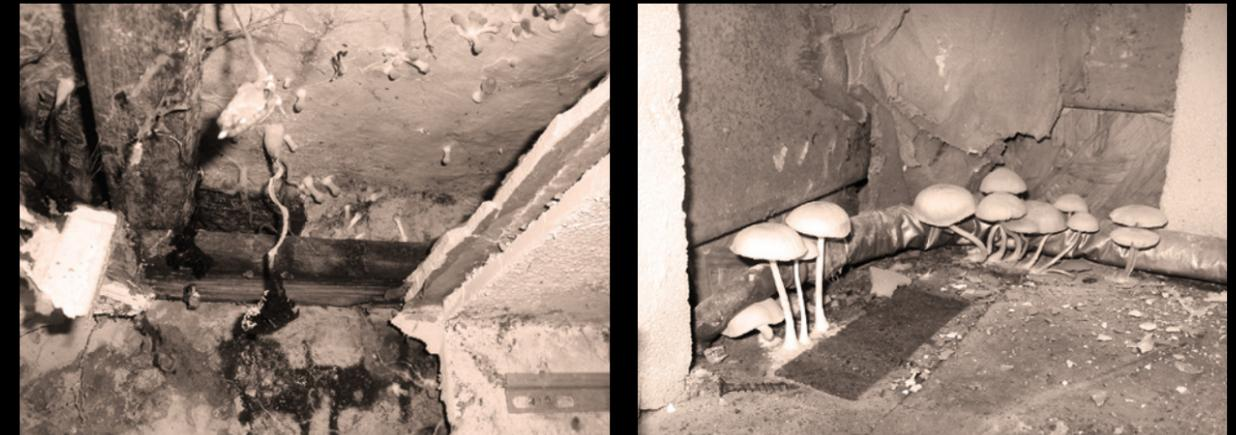
Auf diesen Bildern sind Tintlinge zu erkennen, eine klare Folge eines Wasserschadens im Dämmstoff.
