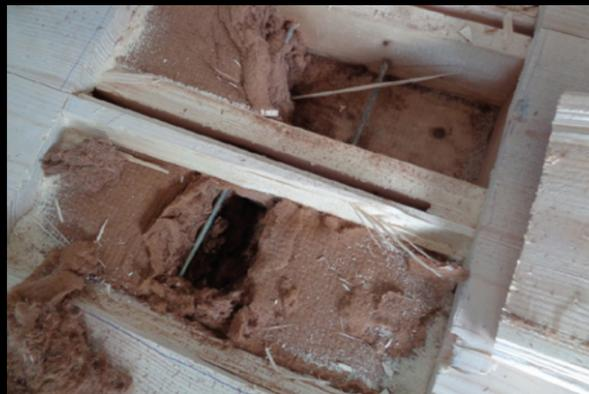
Die Holzfaser-Dämmung saugt das austretende Wasser auf.
