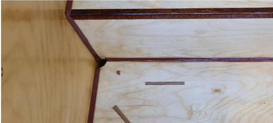
Abbildung 21: Klebenähte aus Epoxidharz in den Innenecken der Bauteilübergänge
