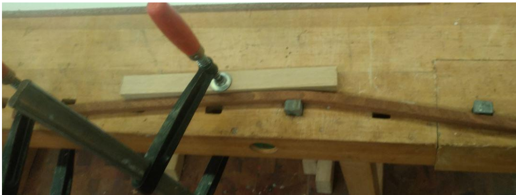
Abbildung 29: Freies Biegen der Sipo-Leisten nach dem Dämpfvorgang
