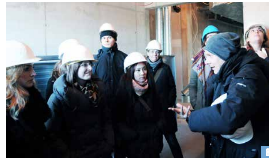
8 Auf der Baustelle: Das neue Gebäude des Fachbereichs Life Science Technologies konnte von Studierenden besichtigt werden.
