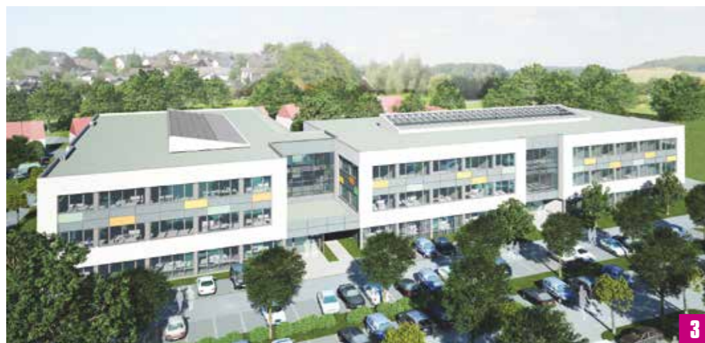
3 So soll es mal aussehen: Nach der Erweiterung des CIIT stehen insgesamt 10.000 Quadratmeter für Forschung und Technologietransfer zur Verfügung.
