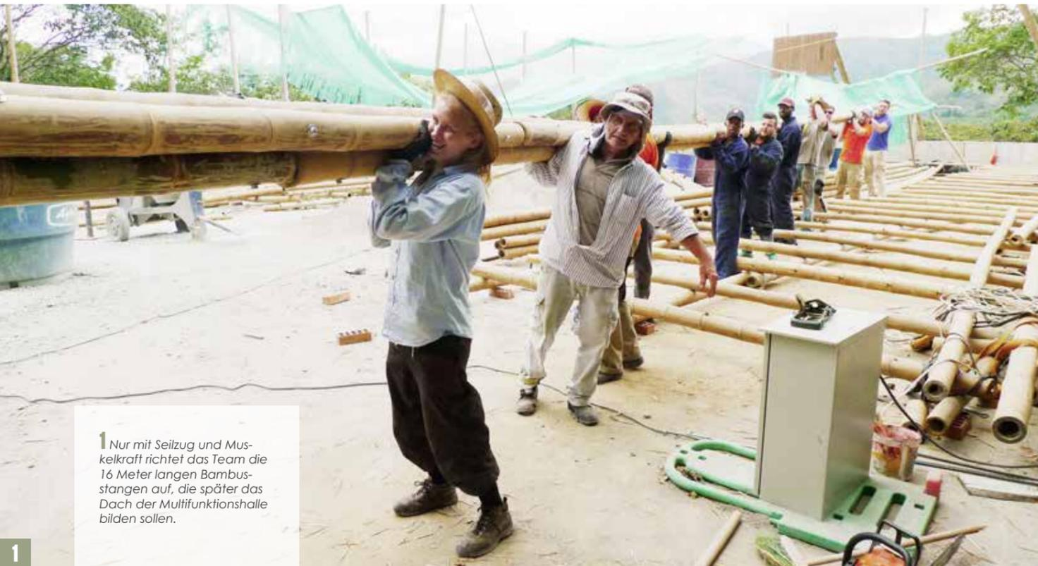
**1** Nur mit Seilzug und Muskelkraft richtet das Team die 16 Meter langen Bambusstangen auf, die später das Dach der Multifunktionshalle bilden sollen.
