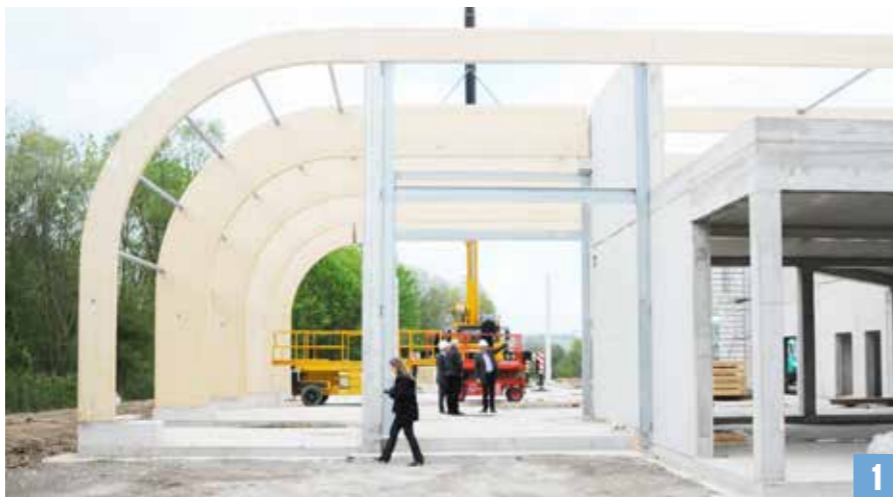
1 Der Rohbau steht, der Bau der SmartFactoryOWL geht zügig voran.
