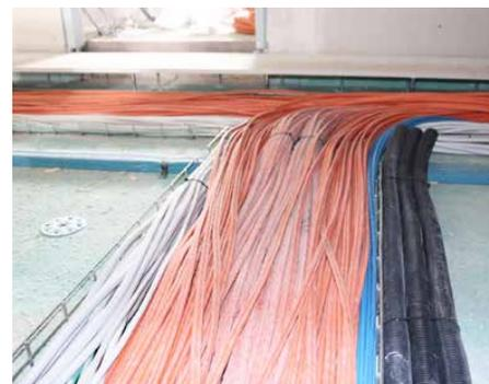
40.000 Meter Daten-, Strom- und Lichtwellenkabel verlegen die Fachleute in dem Neubau des Fachbereichs Medienproduktion in Detmold.
