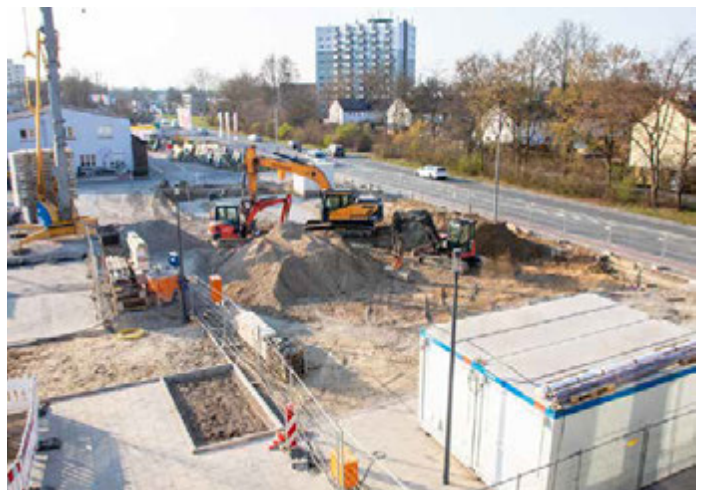
Die Erdarbeiten für das KreativInstitut.OWL sind gestartet.
