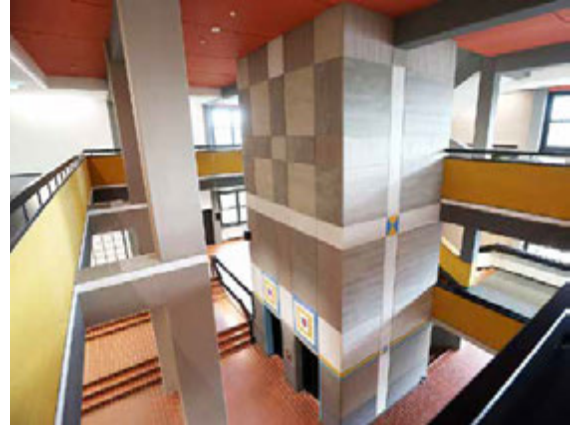
„Wie neu gebaut“ präsentiert sich das Foyer der TH OWL nach der Restaurierung.
