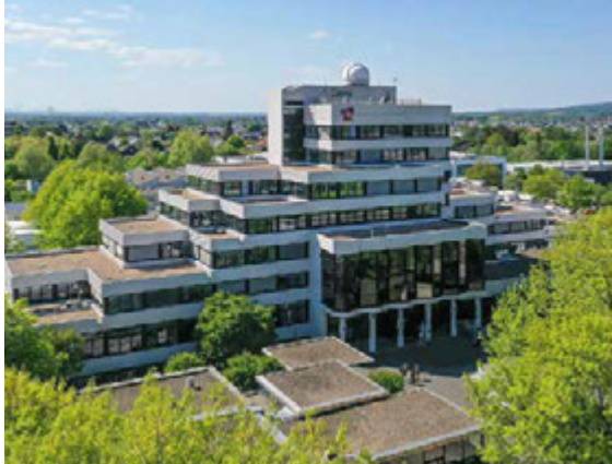
Die Fassade des in den 70er Jahren erbauten Hauptgebäudes wurde saniert und neu gestrichen.
