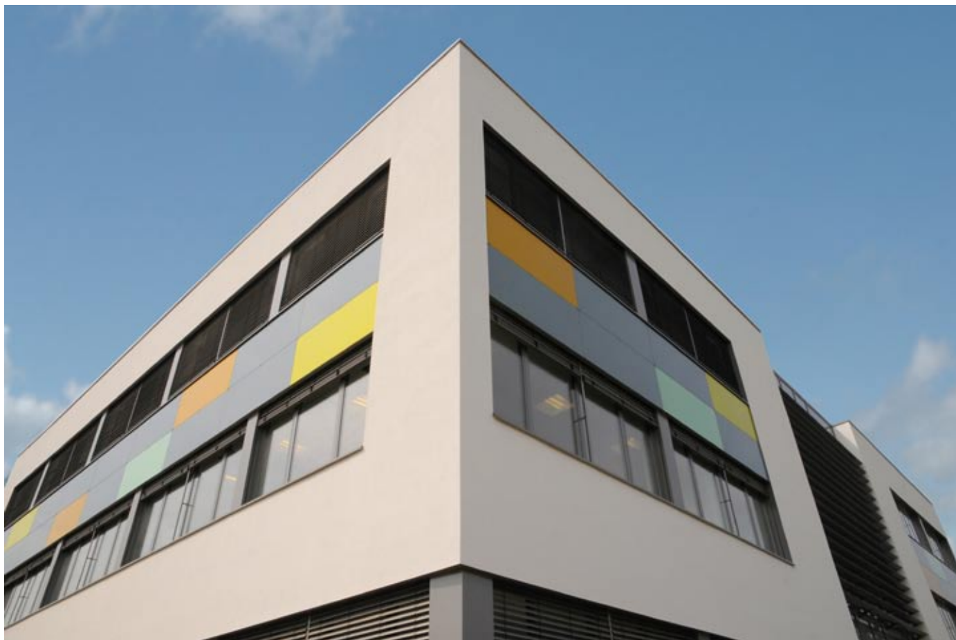
Das Centrum Industrial IT [CIIT] auf dem Campus der Hochschule OWL in Lemgo.
