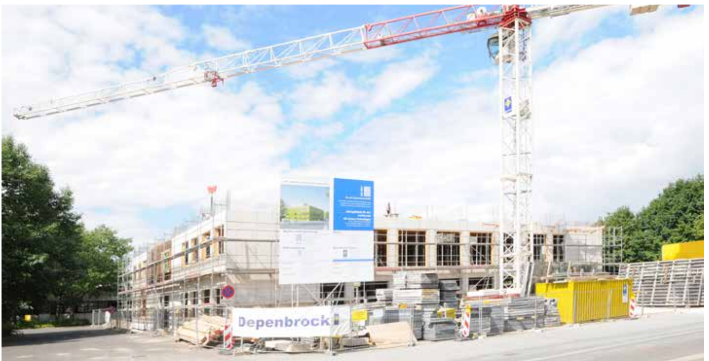
■ Direkt vor dem Hauptgebäude in Lemgo entsteht das neue Laborgebäude des Fachbereichs Life Science Technologies.
